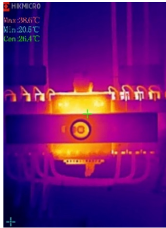
Inspektion von Elektroanlagen
