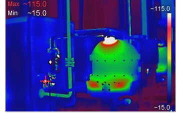
Überprüfung mechanischer Zustände
