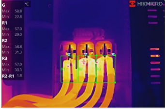
Überprüfung elektrischer Anlagen
